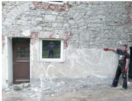
Das alte Deelentor wurde nach Abschlagen des Putzes sichtbar
