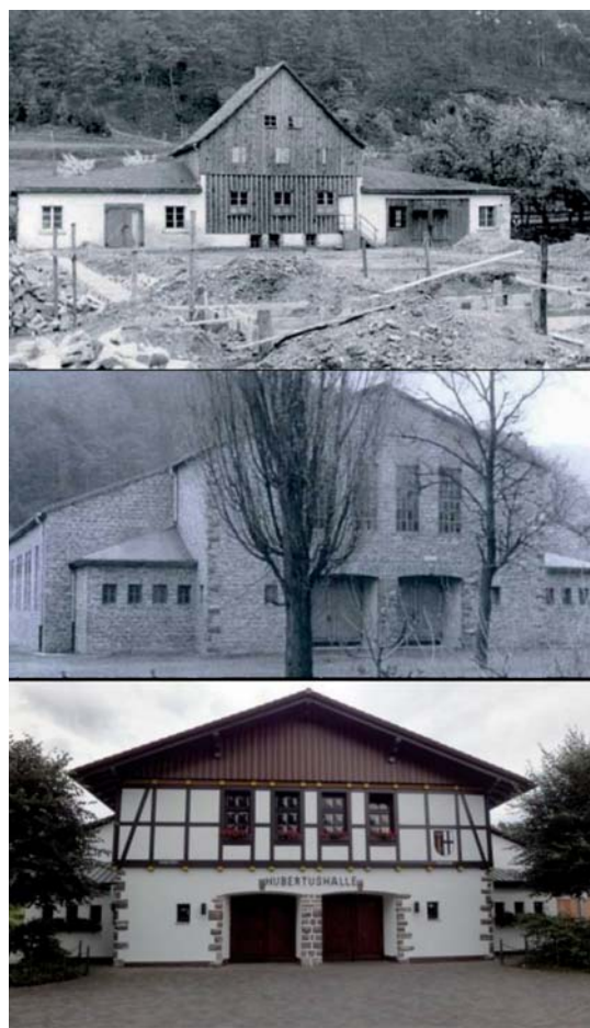
1950 wurde die Schützenhalle Stockum gebaut und über Generationen hinweg instandgehalten und modernisiert. Jetzt folgt die nächste große Investition.
