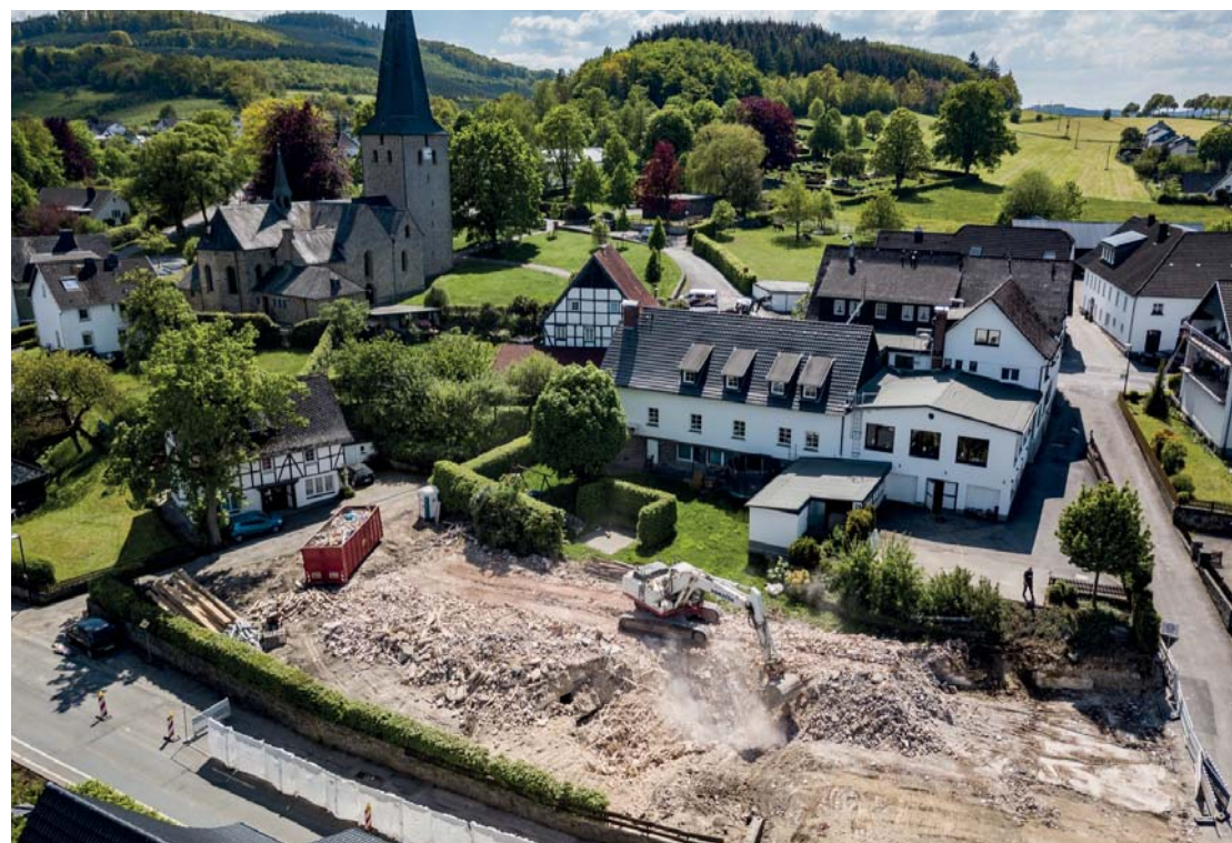
Das Cordes-Gebäude ist abgerissen
