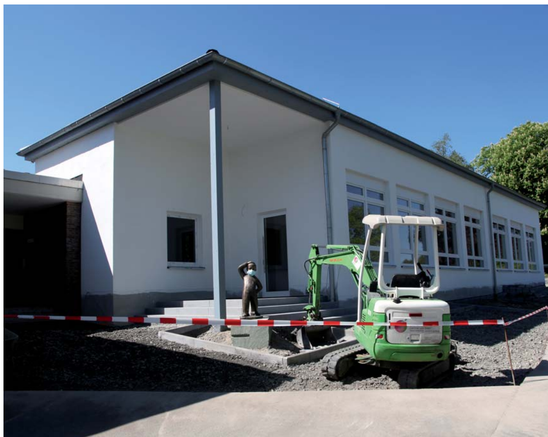
Die Arbeiten am Schulanbau stehen vor dem Abschluss
