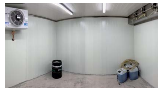
Das Kühlhaus hinter der „Hölle“ wurde kernsaniert. In den nächsten Wochen wird der Bodenbelag noch finalisiert, sodass die Technik danach in Betrieb genommen werden kann.
