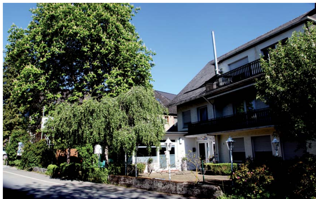
Außenansicht der neuen Pizzeria „106“ gegenüber dem Feuerwehrhaus
