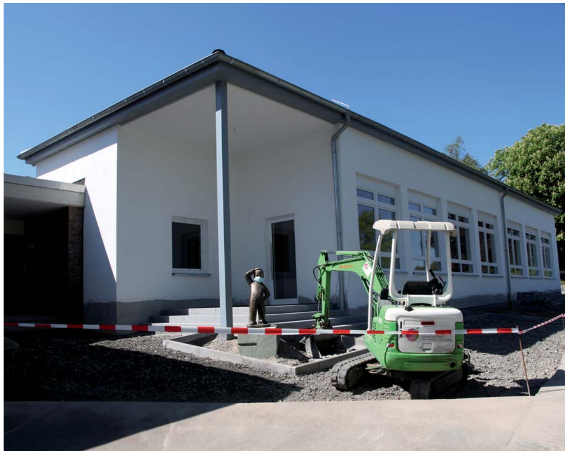
Die Arbeiten am Schulanbau stehen vor dem Abschluss
